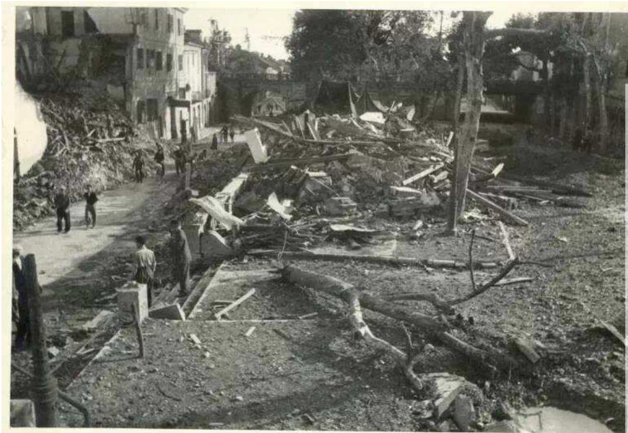
V.le Saffi dopo il bombardamento dell'8 luglio 1944
